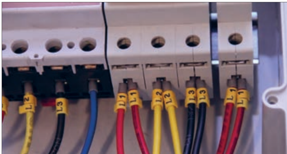
شکل ۲۴- سر سیم و شماره سیم پریز تک فاز
