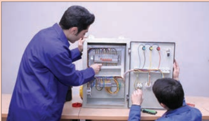
شکل ۳۰- قطعات الکتریکی و غیر الکتریکی تابلو برق
