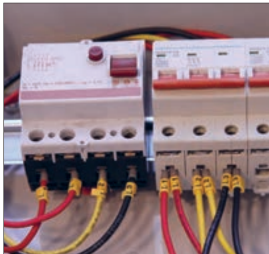
شکل ۲۳- نصب کلید خودکار مینیاتوری و سرسیم و شماره سیم
