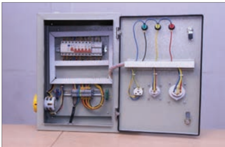
شکل ۵۸- نمای مختلف تابلو توزیع کارگاهی
