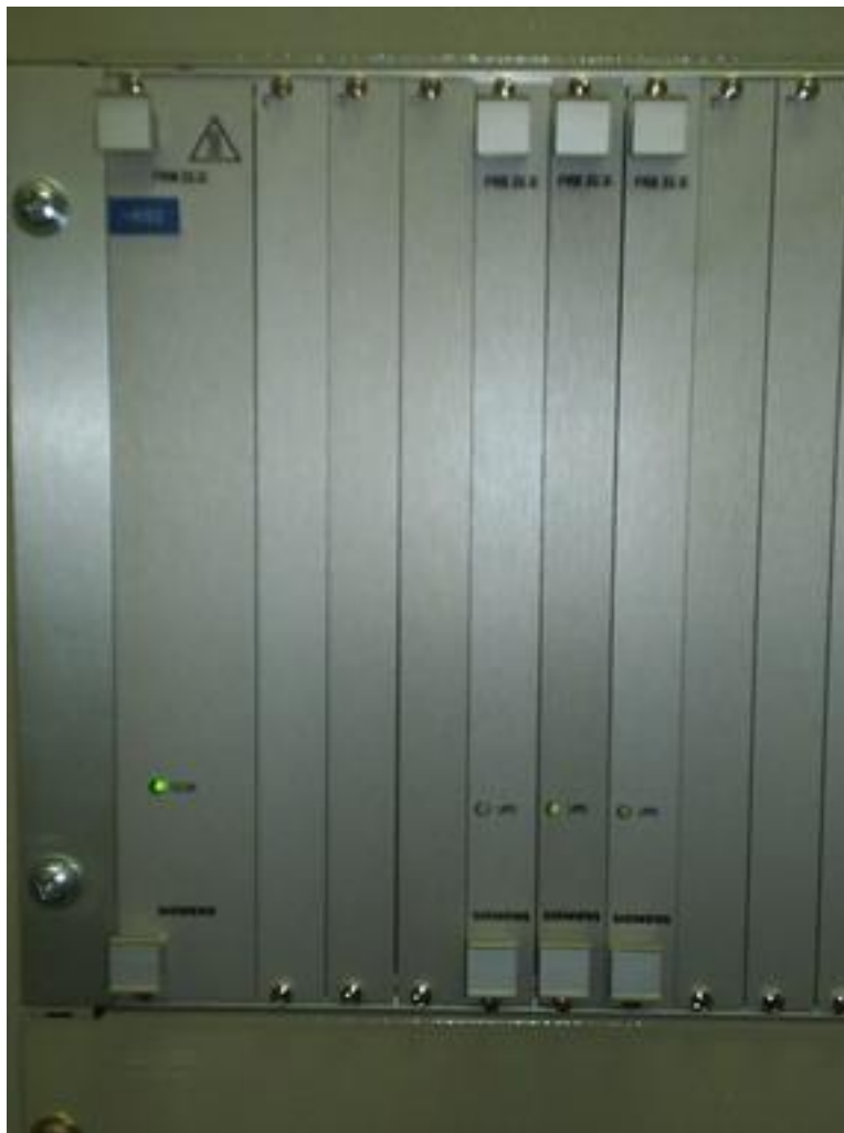
کارت‌های آنالوگ و کارت تغذیه شاسی پایینی
