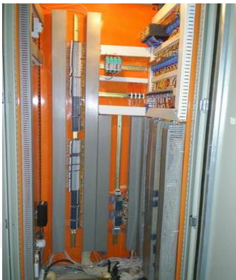
نمونه هایی از تابلو HVI (متمرکز در یک تابلو) در ایستگاه ۲۳۰ صدرا
