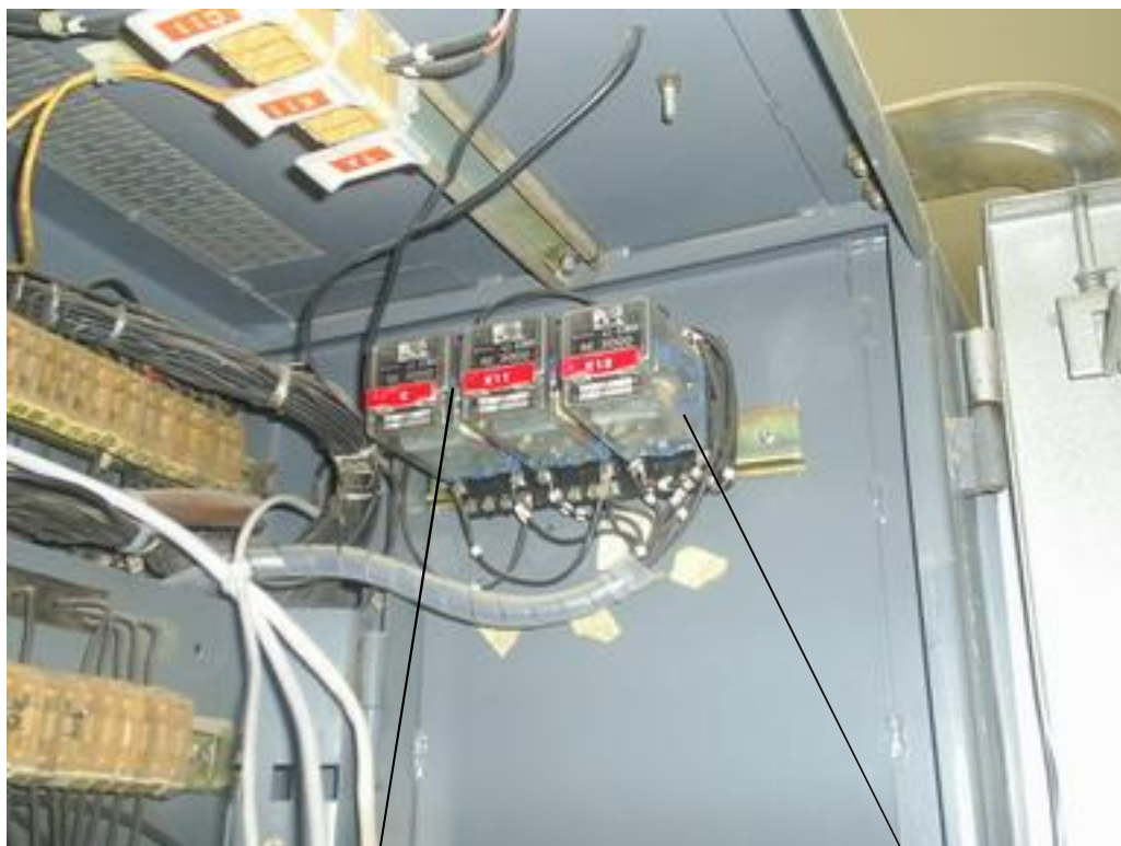
رله ها تجهیزات HVI تعبیه شده در فیدرهای خروجی ترانس دیوسر
