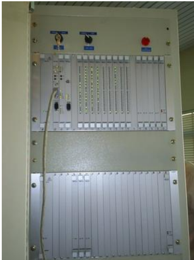
کارت‌های RTU ایستگاه ۲۳۰ صدرا
