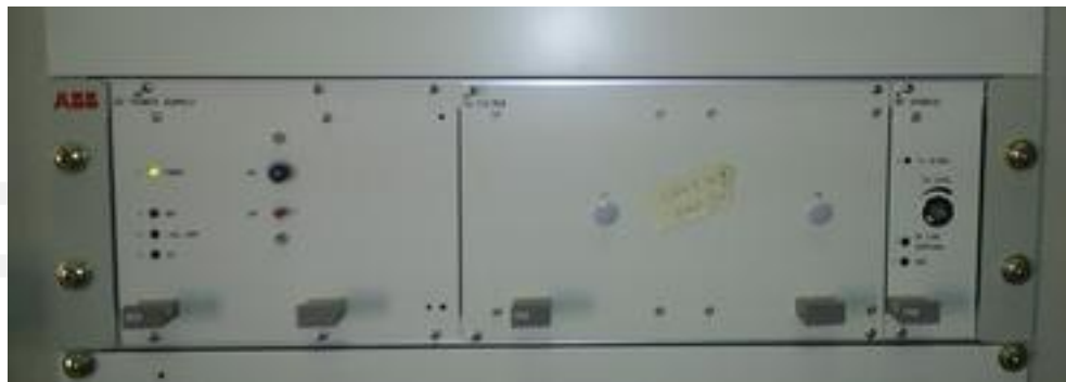
از راست به چپ: کارت هایبرید، کارت Tx، کارت تغذیه
