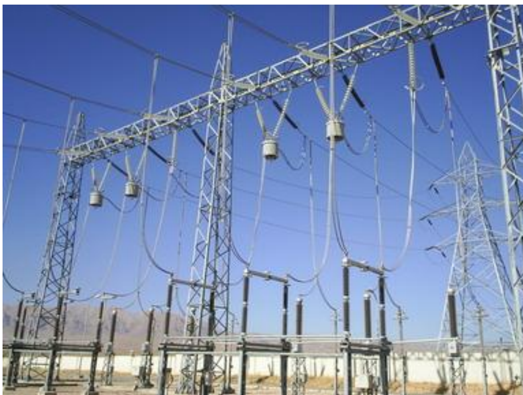
آرایش فیزیکی لاین تراب ها در ورودی ایستگاه صدرا
