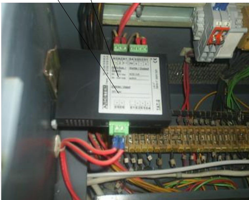
رله ها تجهیزات HVI تعبیه شده در فیدرهای خروجی ترانس دیوسر
