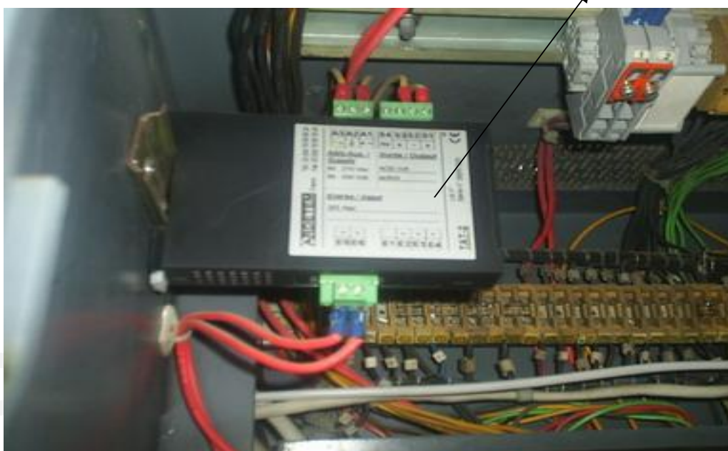
تجهیزات HVI در فیدرهای خروجی
