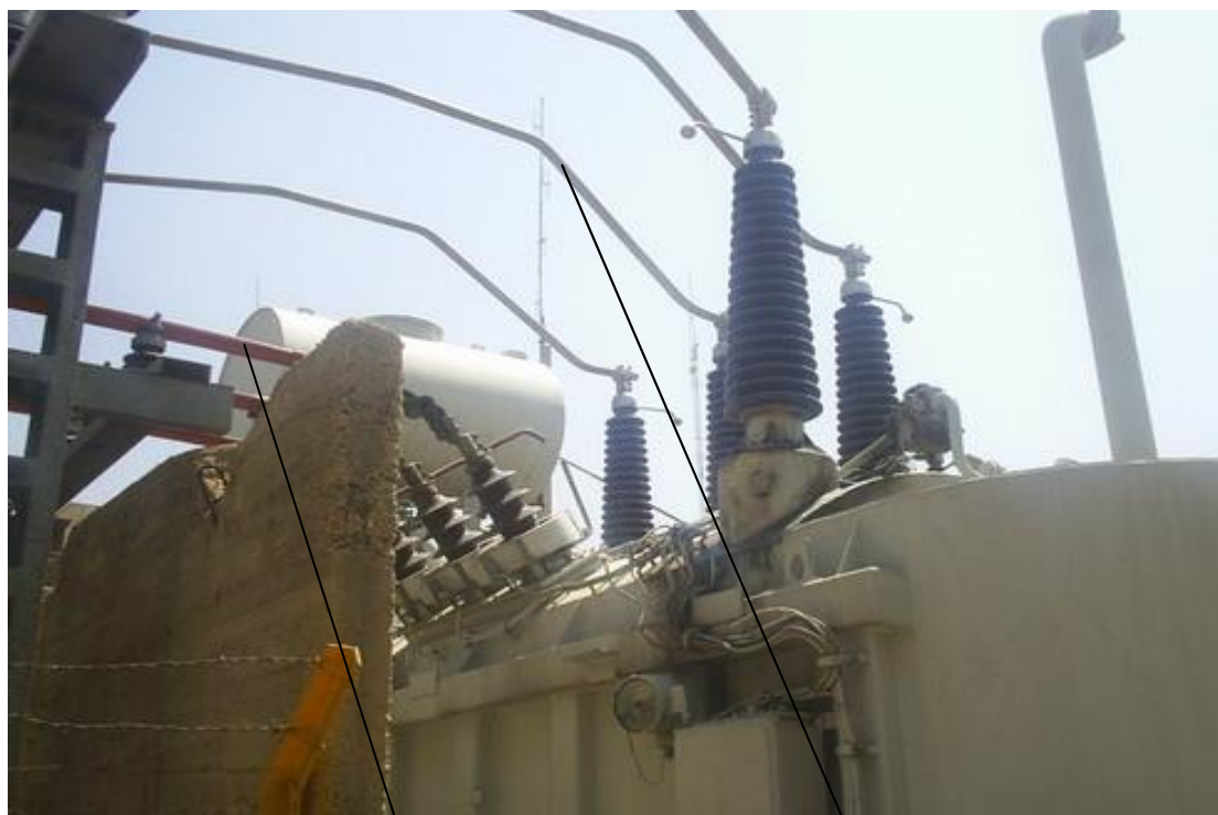
خروجی ها از ثانویه ترانس
