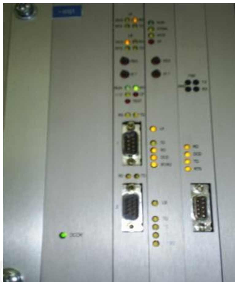
به ترتیب از راست: کارت مودم، کارت I-COM، کارت CPU، کارت تغذیه
