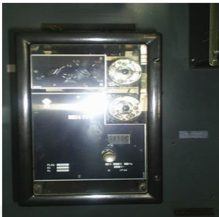
رله دیفرانسیل
