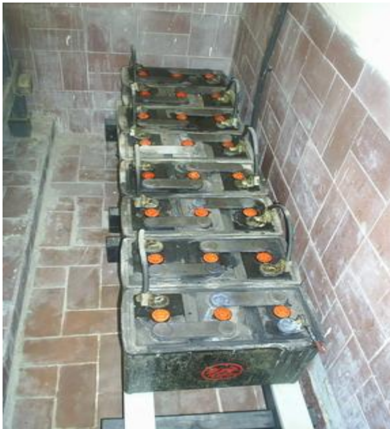
باتری های تغذیه RTU ایستگاه
