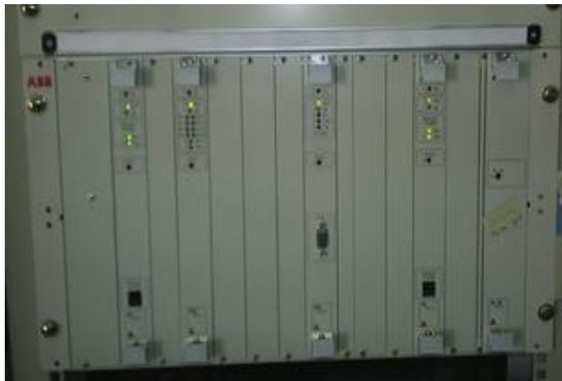
از راست به چپ: کارت RX، کارت LF، کارت پروسسور مرکزی، کارت حفاظت، کارت LF (دو کاناله)
