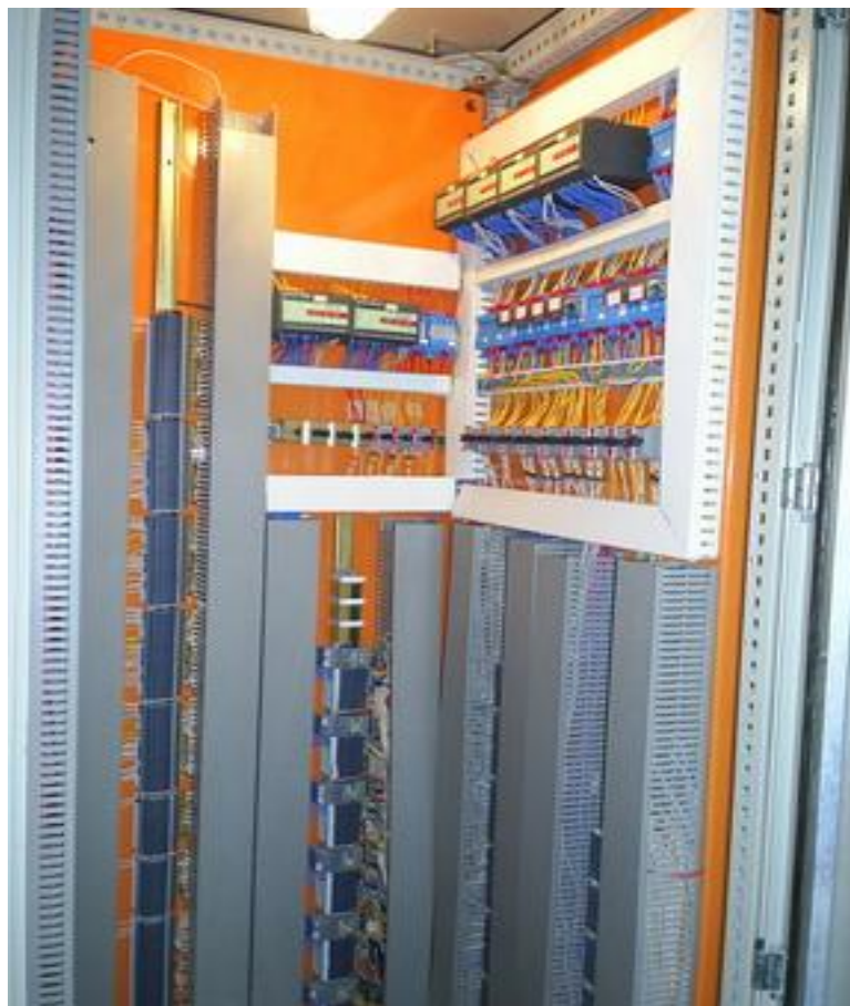
نمونه هایی از تابلو HVI (متمرکز در یک تابلو) در ایستگاه ۲۳۰ صدرا
