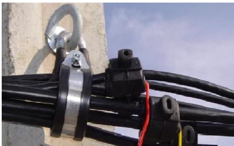
شکل ۲۴: نمای یک کلمپ فشار ضعیف در شبکه اجرا شده
