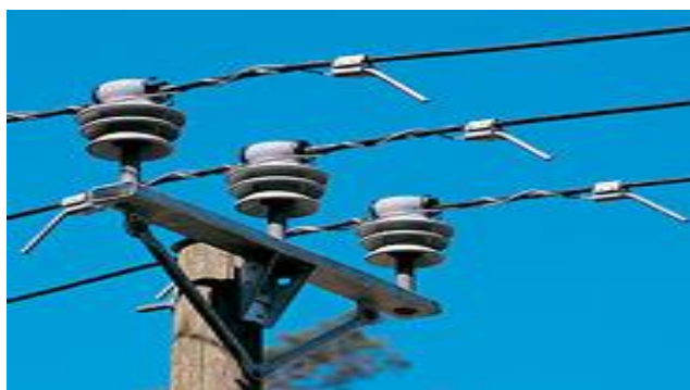
شکل ۲۰: نمای شبکه اجرا شده با هادی روکشدار
