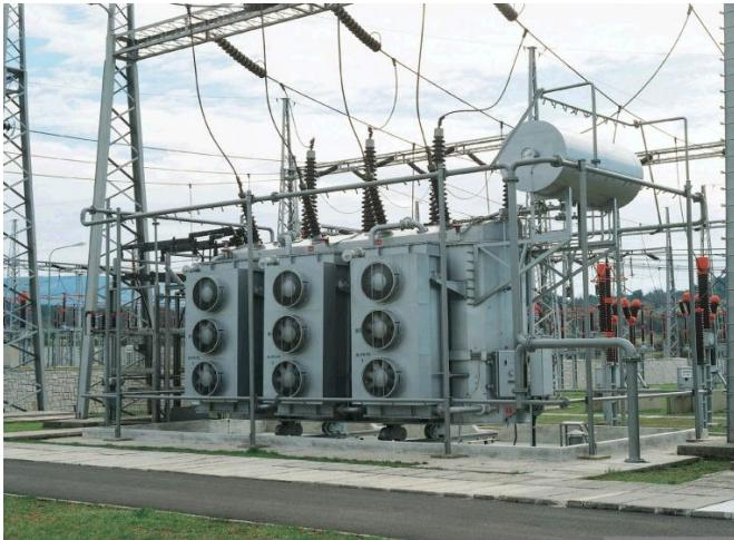
شکل 1. یک ترانسفورماتور ولتاژ بالا
