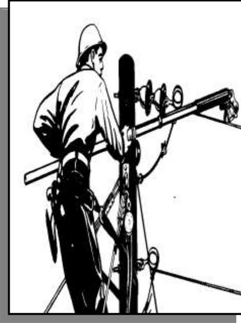
قرار دادن سیم گیر لولایی بر روی سیم
