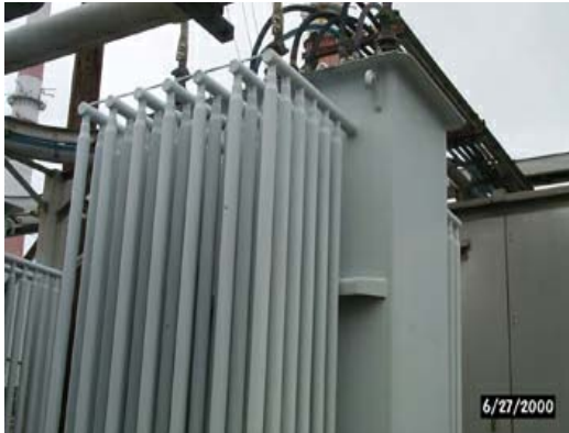
شکل - ۵ : عدم خنک کنندگی مناسب ترانسفورماتور در اثر کاهش سطح روغن
