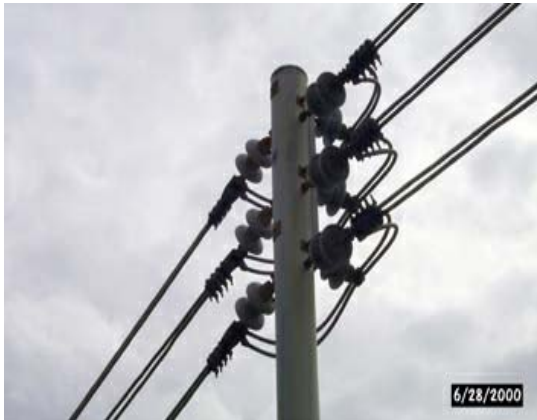
شکل - ۶ : خرابی Jumper در محل اتصال پیچها برروی هادی شبکه توزیع نیروی برق
