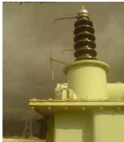
**ب- برقگیر لوله‌ای :** این نوع برقگیر شامل یک فاصله هوایی برای جرقه زدن در فضا و یک فاصله دیگر در درون یک محفظه مخصوص که با هم به صورت سری قرار دارند، می‌باشد.
