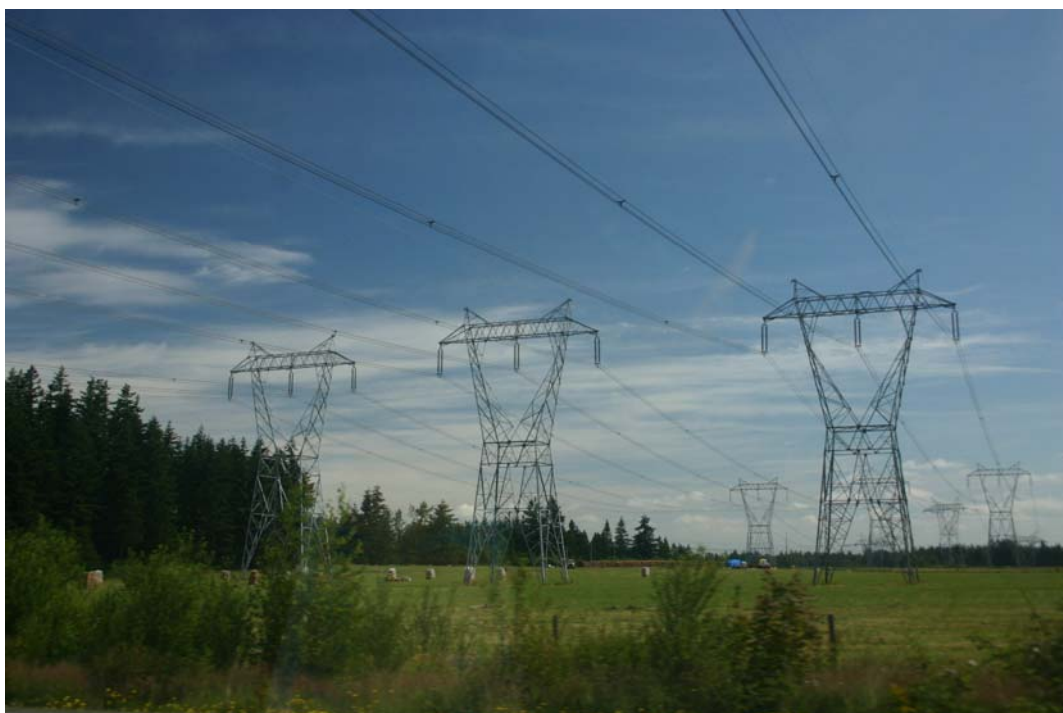
شکل ۱۰) برج با آرایش افقی هادیها
