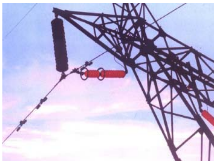
شکل ۴۵) استفاده از برقگیر خط بر روی دکل
