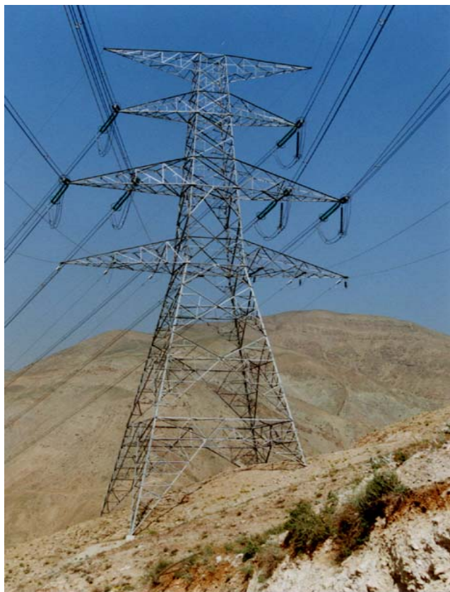
شکل ۱۹ خط انتقال چهارمداره
