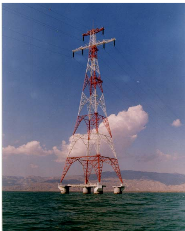
شکل ۴۳) استفاده از میله برقگیر بر روی دکل
