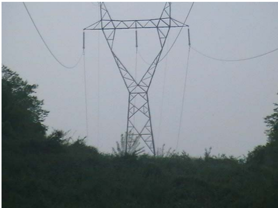
شکل ۱۴) نمایی از یک برج آویزی
