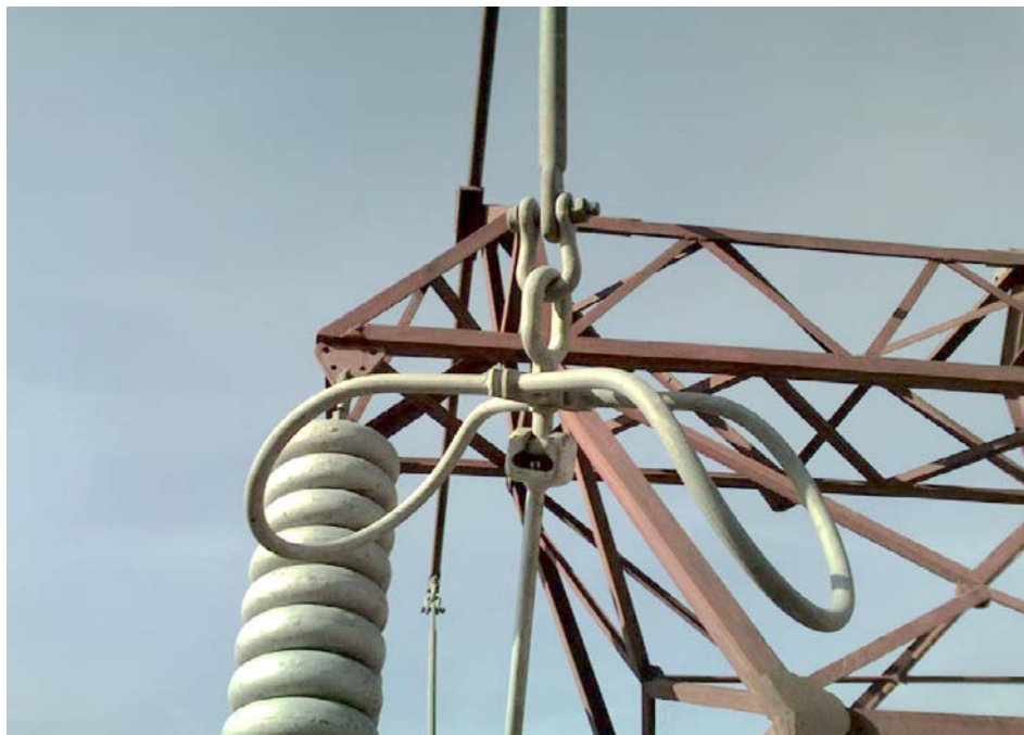
شکل ۳۷) استفاده از Shackle , Ball Oval Eye , Arcing Rocket
