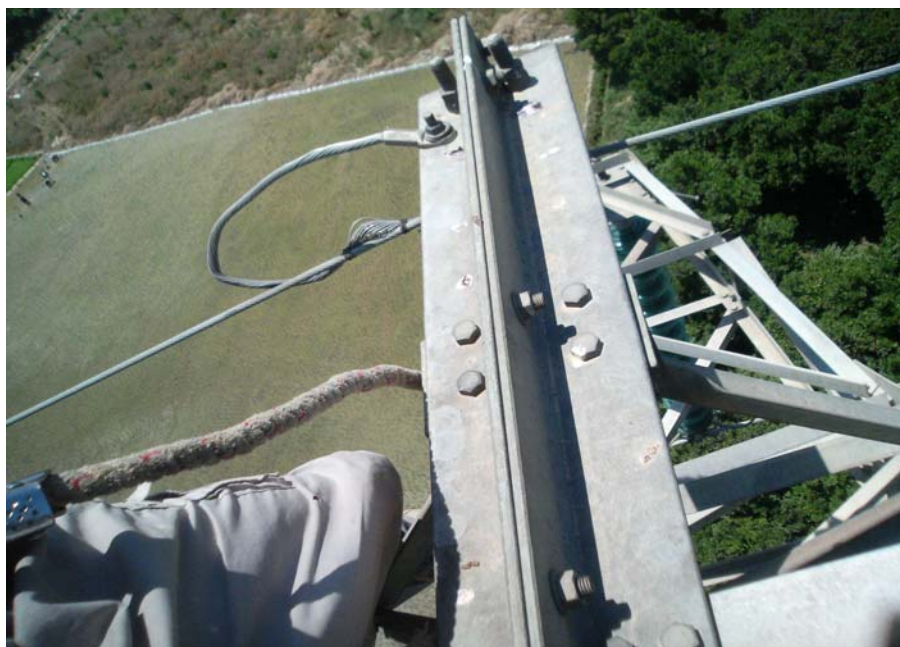
شکل (۴۲) اتصال سیم محافظ هوایی به بدنه دکل
