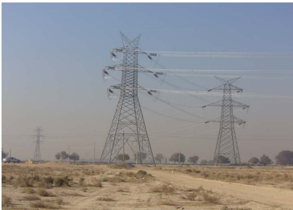
شکل ۱۵) نمایی از دکل های کششی
