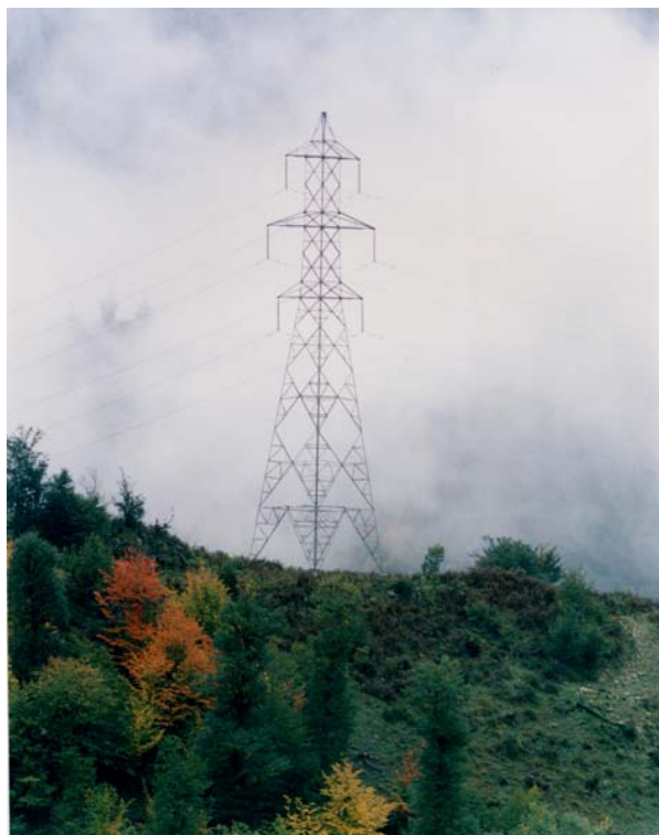
شکل (۱۱) خط انتقال با آرایش عمودی فازها
