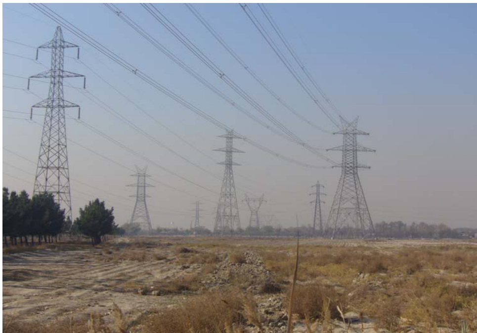
شکل ۱۸) نمایی از خط انتقال دومداره
