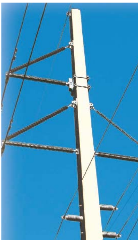
شکل ۲۷) کاربرد مقره اتکایی بعنوان بازوی دکل
