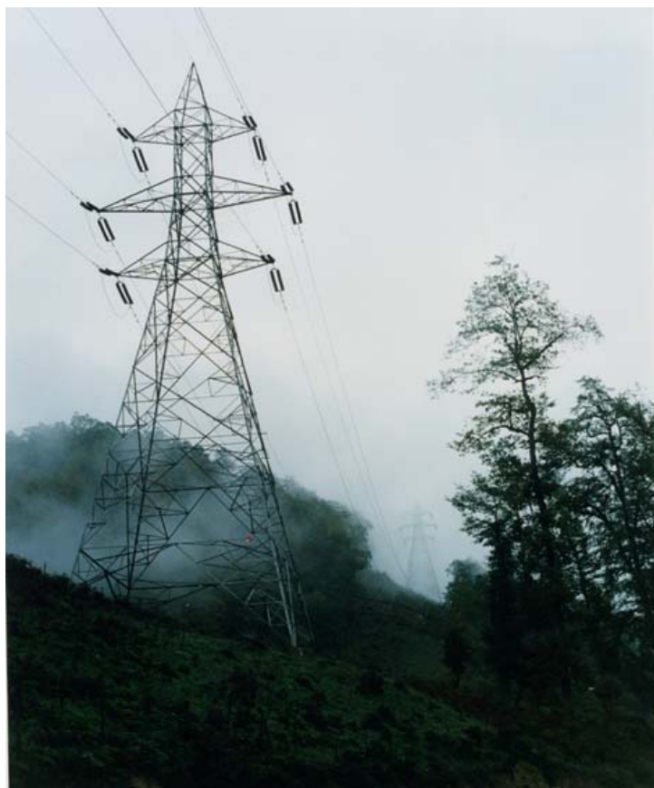
شکل ۱۸) نمایی از خط انتقال دومداره
