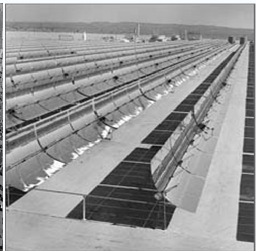
استفاده از کلکتور U شکل برای تولید برق، سیال انتقال دهنده گرما روغن است
