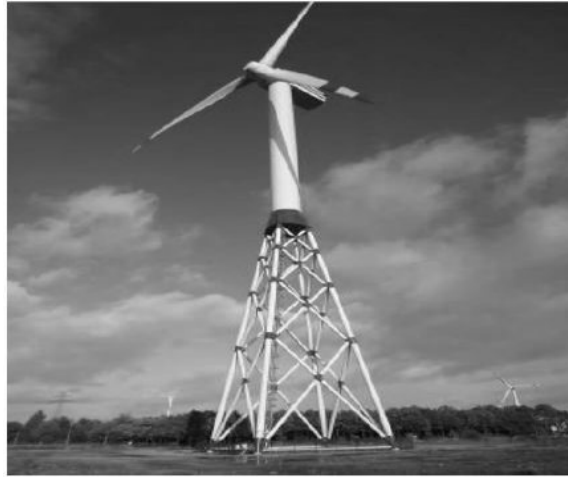
شکل ۵-۹ نمونه‌ی پوشش نصب‌شده برای توربین ۵ MW در خشکی (عکس توسط ژاک روئر ۱ گرفته شده است)
