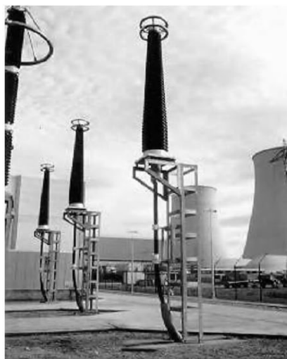
شکل ۷-۱۵ پایانه 400\text{ kV} با عایق چینی
