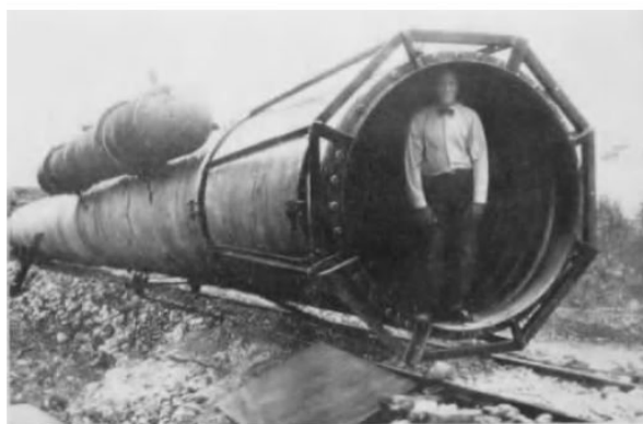
شکل ۱۲-۱۰ بخشی از CWP به قطر 1.6\text{ m} بر روی ریل خود
