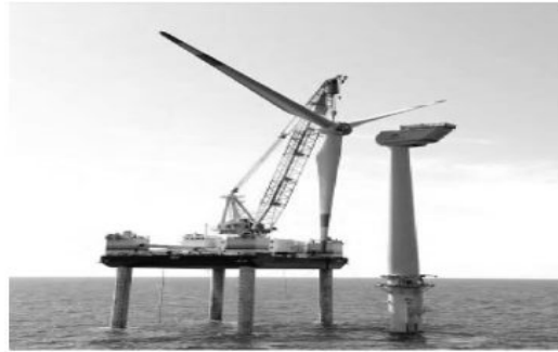
شکل ۵-۱۱ مونتاژ یک توربین بادی 5\text{ MW} با استفاده از بارج بالابر. روتور به 100\text{ m} بالای سطح آب بالا برده می‌شود (© DOTI GmbH)
