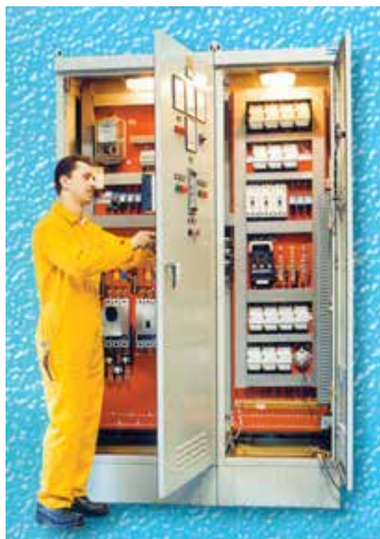
شکل ۲-۹- نمونه‌ای از تابلو توزیع برق
