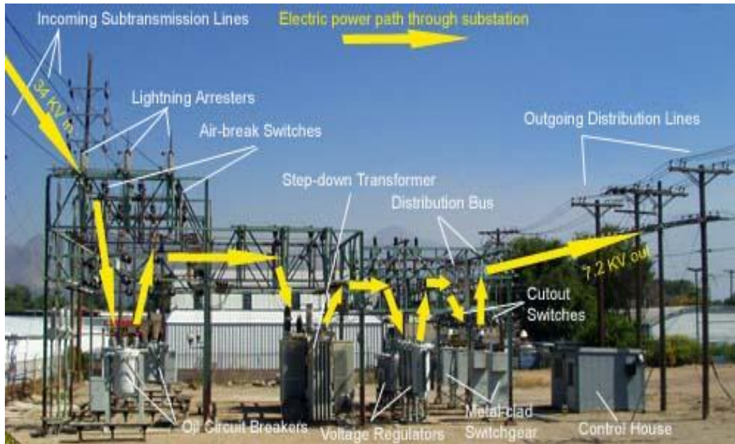
شکل 2 : نمای یک پست برق
