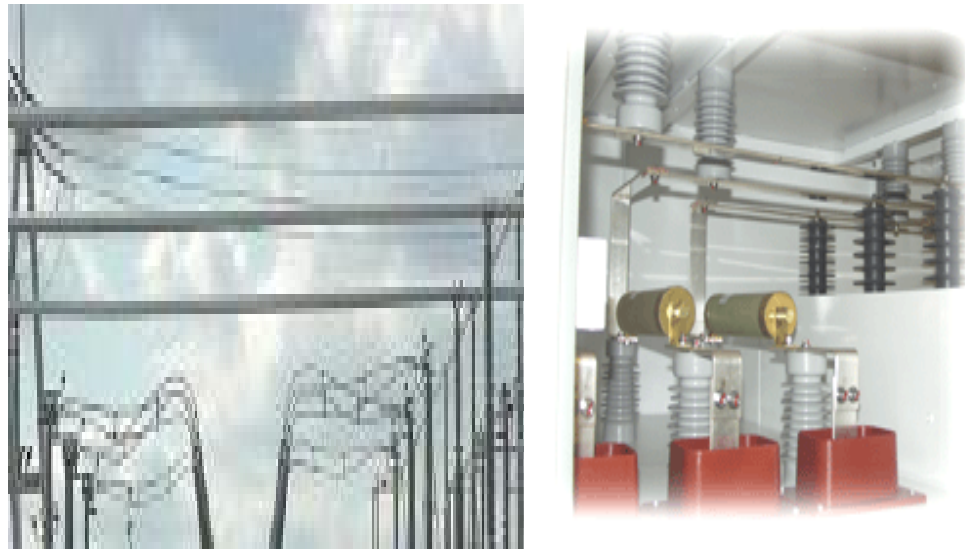
شکل 14- نمای شینه به شکل تسمه ولوله
