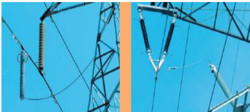
شکل 26 : زنجیره مقره در محل برج یک خط فشار قوی
