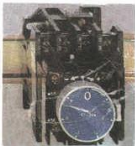
شکل ۲۴-۸- ب- نمای تایمر نیوماتیکی
