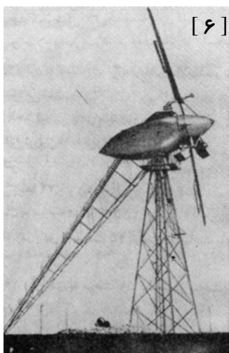
شکل ۵- توربین بادی ۱۰۰ کیلوواتی که روسها ساخته اند. با حرکت دایره ای شکل پایه فلزی مورب روی زمین، توربین همواره در جهت باد قرار می گیرد. [ ۶ ]
