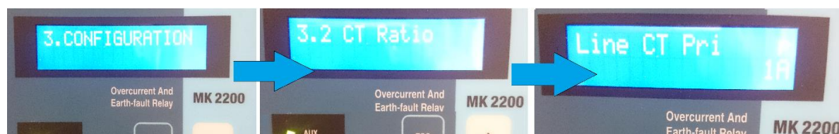
شکل ۵۷ - تنظیم ظریب CT در رله MK2200
