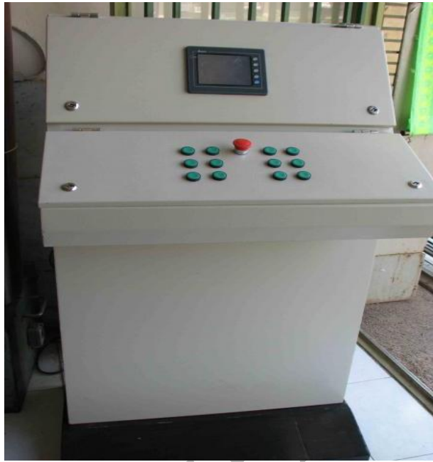
تابلو های حفاظت و کنترل
