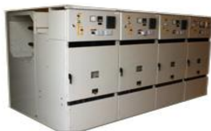
تابلو توزیع فشار متوسط
