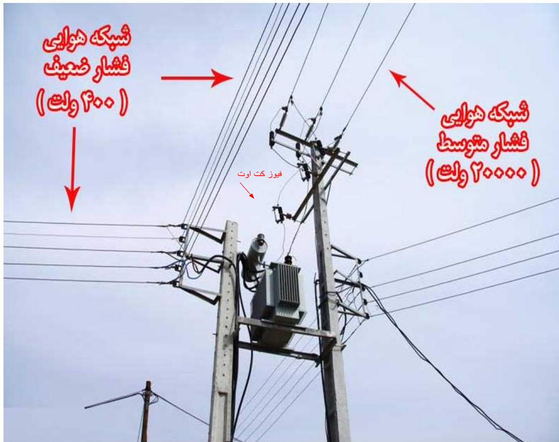
فیوز های کات اوت نصب شده بر روی خط فشار متوسط 20 کیلو ولت
