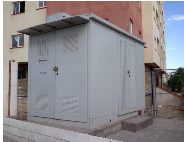
(الف): یک نمونه پست پیش‌ساخته کمپکت فلزی
