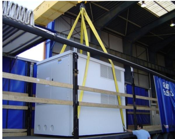
شکل (۱۵): طریقه جابجایی مناسب پست پیش‌ساخته کمپکت با استفاده از تسممه غیرفلزی
