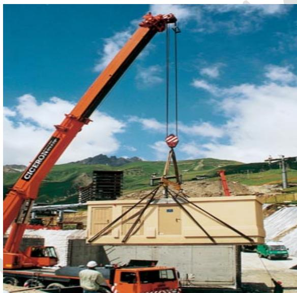
شکل (۱۶): طریقه جابجایی مناسب پست پیش‌ساخته کمپکت با استفاده از تسممه غیرفلزی و تیر حمال
