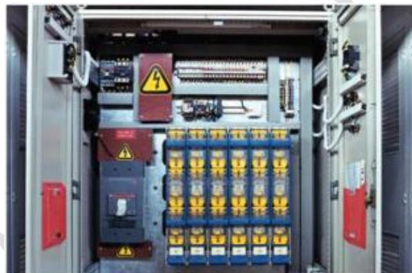
شکل (۷): یک نمونه از شکل واقعی تابلوی فشار ضعیف
