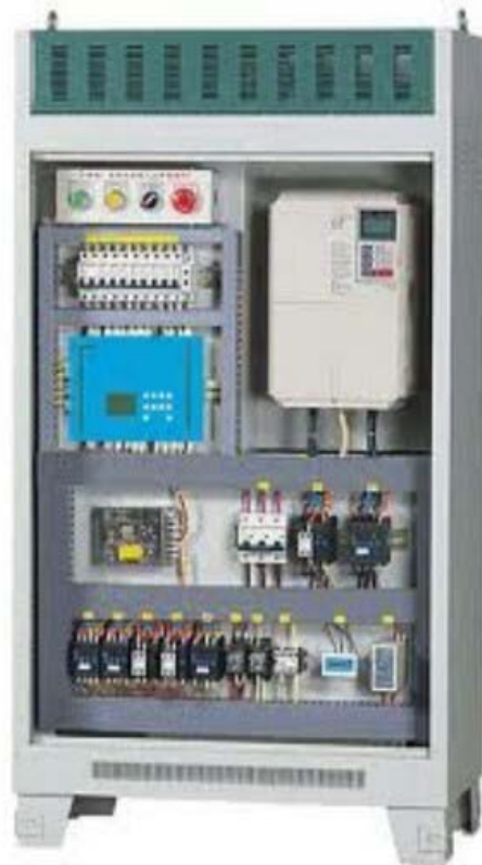
شکل (۴-۷). نمایی از داخل یک تابلو روشنایی
